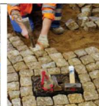
Kleinpflaster im Diagonalverband
