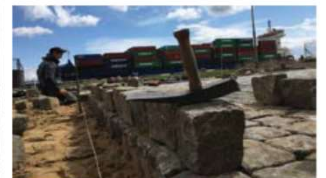
Als Subunternehmer für einen GalaBau-Betrieb hat die Firma den Belag einer historischen Schiffstankstelle im Hafen Brunnbüttel rekonstruiert.
