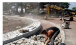
Bagger und Rüttelplatte
