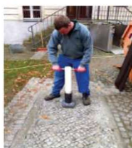
Verdichtung mittels Handramme
